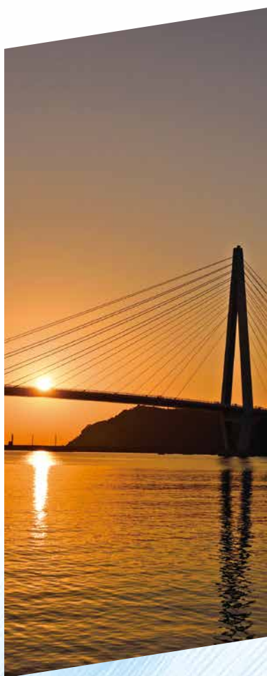
浜田市 浜田マリン大橋
