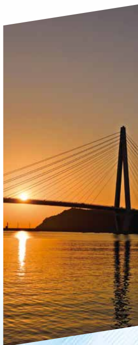
浜田市 浜田マリン大橋
